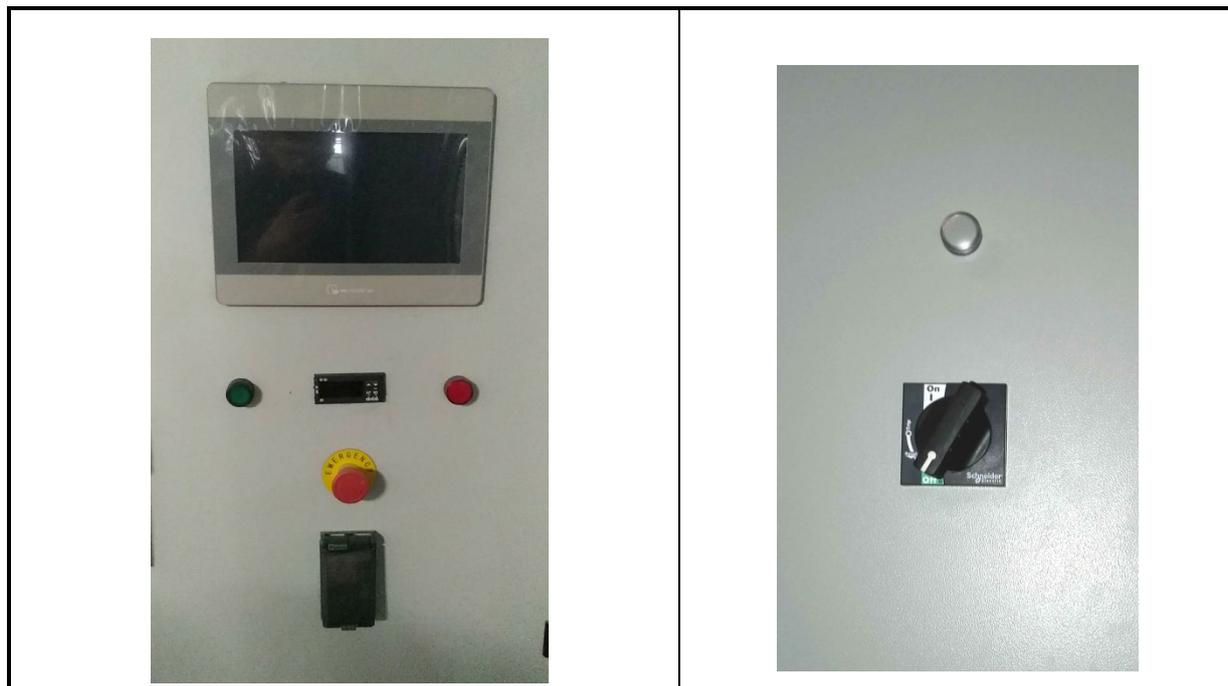
1、主开关（右图，下侧旋转开关）
